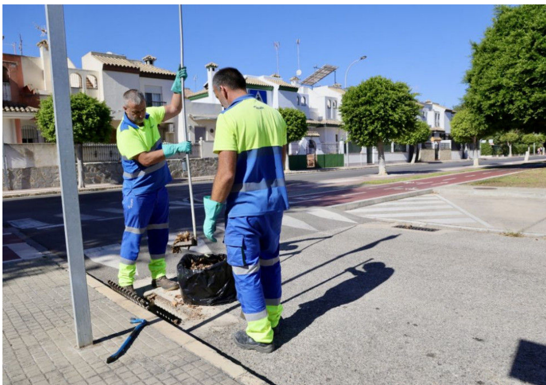
Dos operarios trabajando en la limpieza de imbornales
